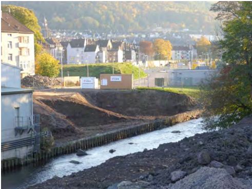
Foto: Baustelle Bahnhofshinterfahung, einseitige Verbesserung der Uferstruktur, Raschke
